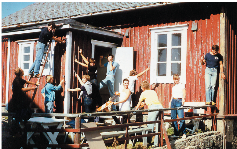
Ett glatt arbetslag sommaren 1982 har äntligen kunnat börja måla på husen. Fönsterarbeten är väldigt tidsödande.
